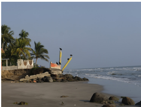
Figura 4. La erosión de la playa ha provocado la pérdida de la primera línea de casas en Las Barrancas, municipio de Alvarado. Fotografía M. Guevara.
